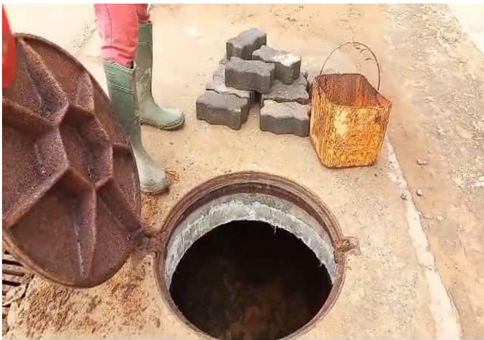
Titre : Opération de curage et débouchage des exutoires et canaux
