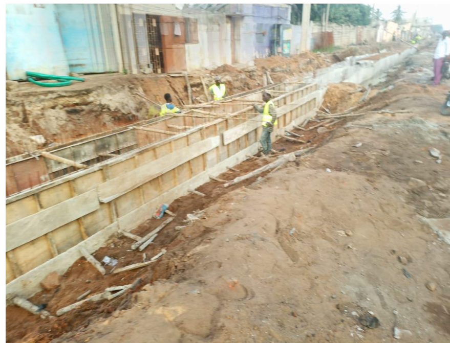
Titre : construction de caniveaux sur le boulevard Mobutu
