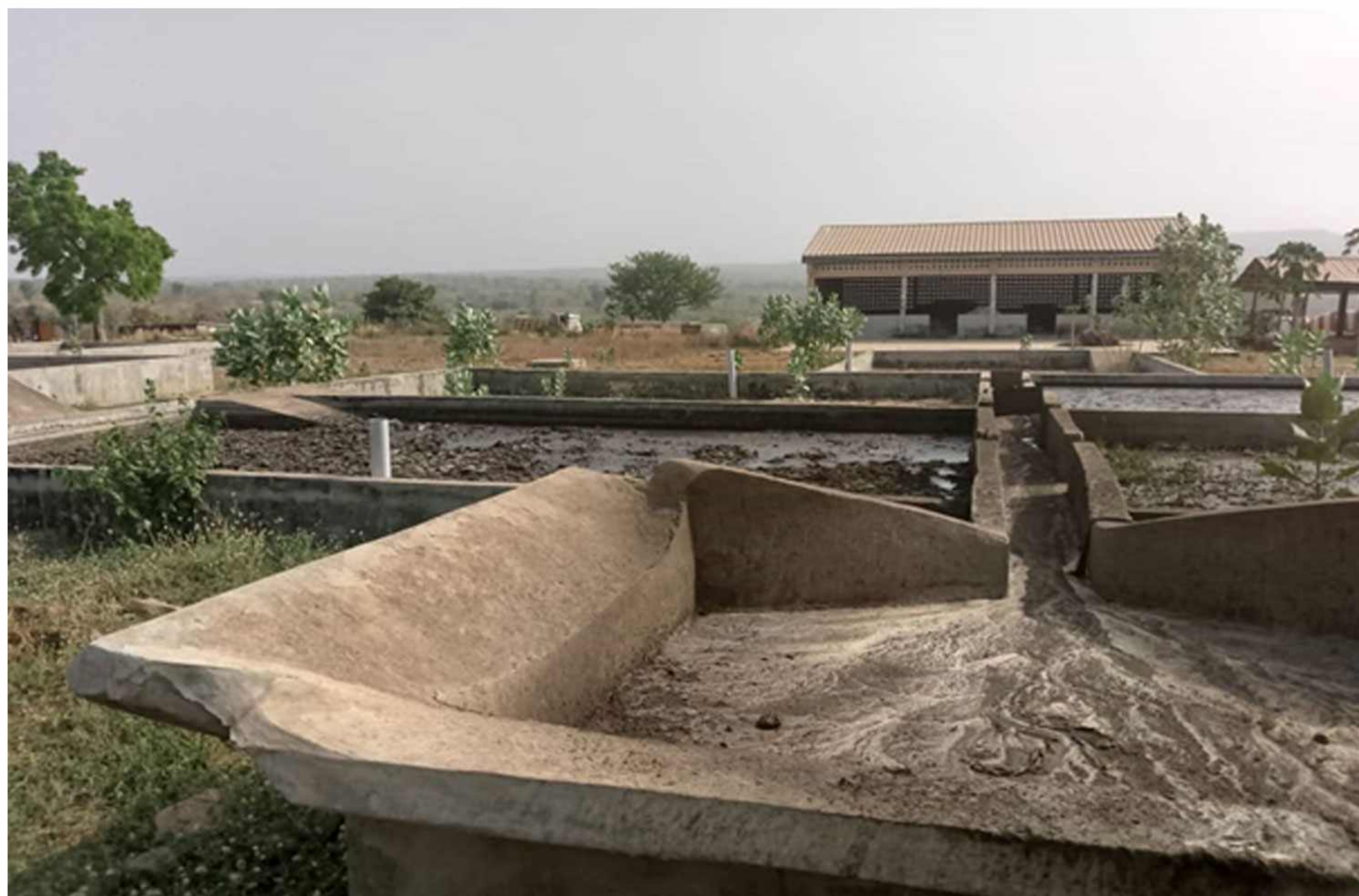
Station de traitement des boues de vidange à Sokode
